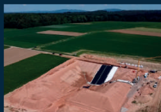
Bracht, Niemcy 26.600 m 3 - w budowie 2024
