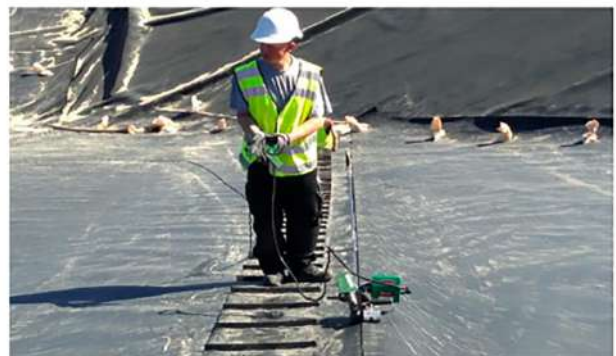
Rysunek 4-1 Podwójne spawanie wykładziny HDPE. Spaw testowany jest poprzez powietrzną próbę ciśnieniową kanału pomiędzy spoinami. Źródło: materiały Solmax.
